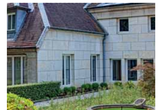
13 Détail de la façade du pavillon d'archéologie. 2023. Gérard Dhenin.
