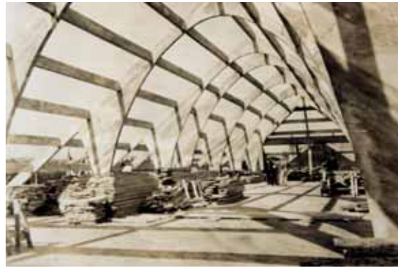
1 Julien Polti et René Tournier, construction de la charpente en béton de la berne Est de la Saline royale. 1930. Archives départementales du Doubs, 120J36-37. Emmanuel Laurent.
