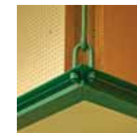
12 détail de la structure de la cabine de projection, de l'amphithéâtre Donzelot. 2023. Gérard Dhenin.
