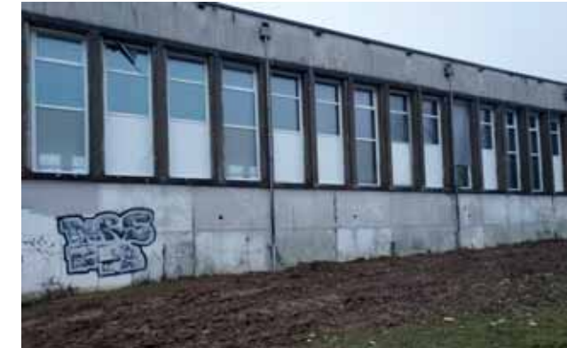
6 Mur extérieur de la bibliothèque universitaire avant travaux. Octobre 2020.
