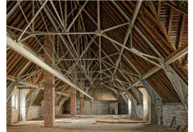
Détail de la charpente métallique de l'une des écuries. 2023. Gérard Dhenin.
